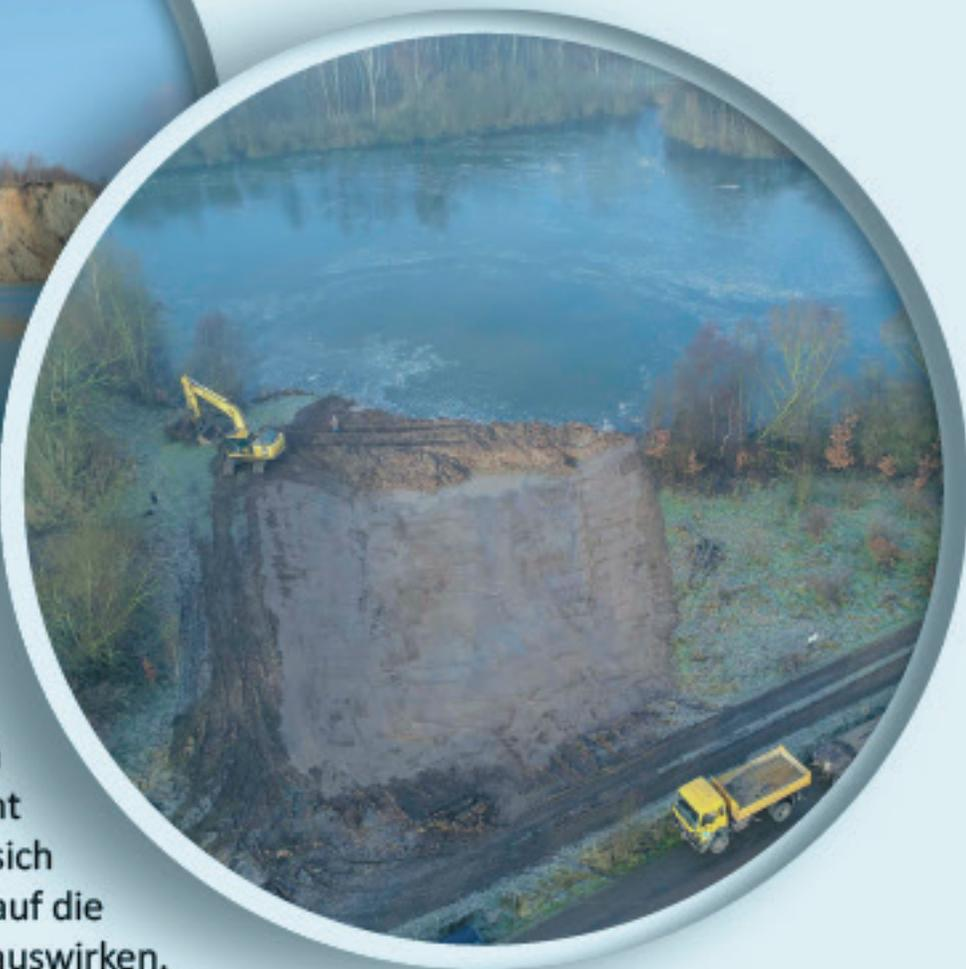
Mit Hilfe von Baggern wurden Teilabschnitte der naturfernen, steilen Ufer zu Flachwasserzonen umgestaltet. Anschließend erforscht das Projekt BAGGERSEE, wie sich die neuen Flachwasserareale auf die Tier- und Pflanzenwelt auswirken.
