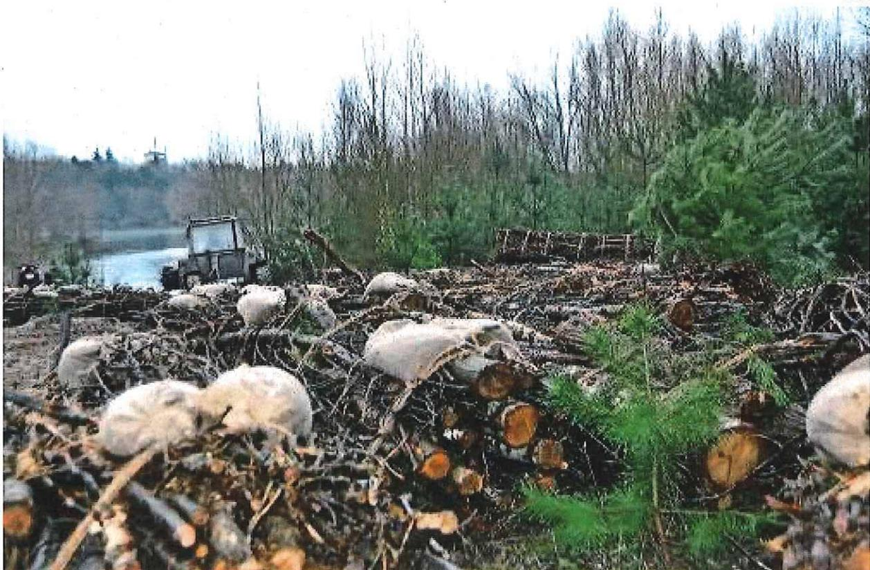
Am Boden halten: Die Holzbündel müssen mit kiesgefüllten Jutesäcken beschwert werden.
