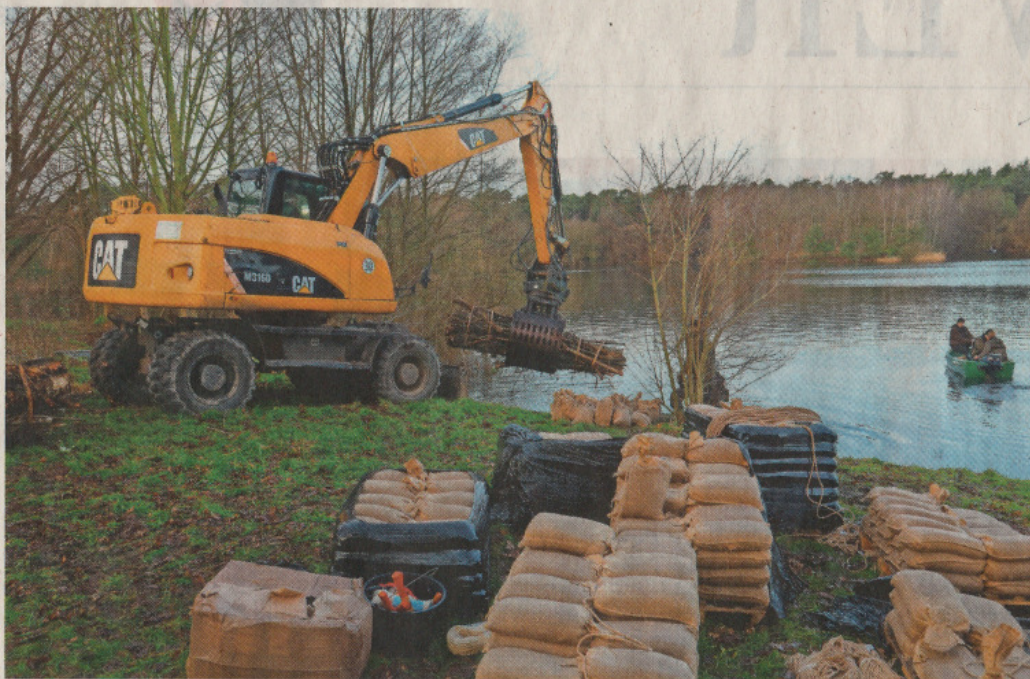
Bündelweise Buchenholz, beschwert mit Kiessäcken aus Jute: Unter Wasser sollen Laich- und Brutgebiete für Fische, Insekten und andere Lebewesen entstehen.
