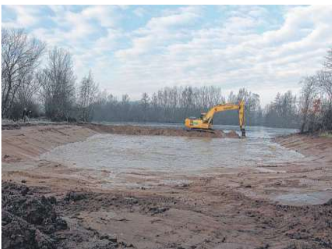
Gestern öffnete Baggerfahrer Edmund Fehler den Damm.
