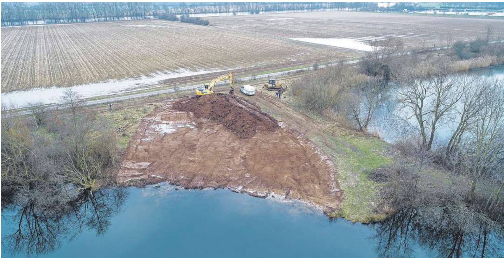
In dieser Woche wurde an der Donnerkieskuhle in Mehlbergen eine Flachwasserzone geschaffen, die Artenvielfalt und die fischereiliche Qualität fördern soll.
