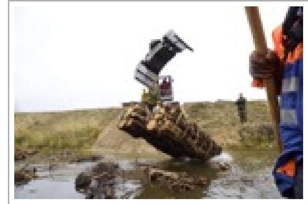
Der Eintrag von Totholz an den Ufern von Baggerseen soll den Fischbesatz in den Gewässern positiv beeinflussen. (Foto: Anja Gruner)
